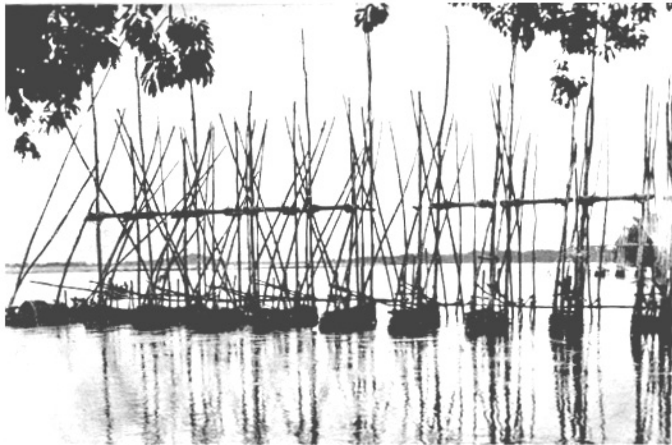
Planche LXIV ( Photo 38 ). — Montage de la noria ; même état des travaux, vue du côté du fleuve.
