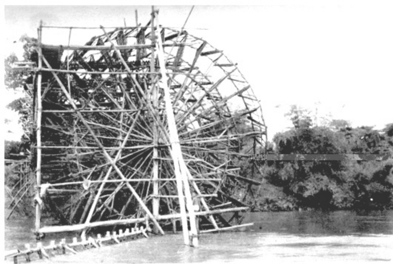
Planche LXVII ( Photo 41 ). — Montage de la noria : la noria est terminée ; les palettes et les godets sont en place ; les trévisions de serrage sont nettement visibles ; remarquer le portement de l'essieu ; à gauche, au premier plan , le barrage, encore peu étanché ; à droite, au point où les palettes émergent, ensemble du coursier.
